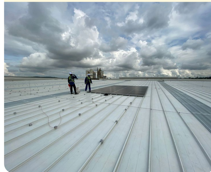
Cubierta Bodega Lote O – Zona Franca La Candelaria
