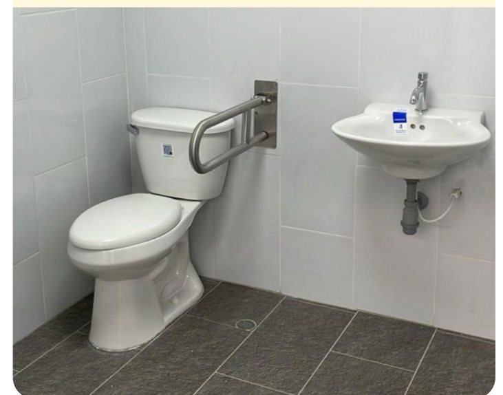
Baños Proyecto Bodega Importec – Zona Franca de Bogotá
